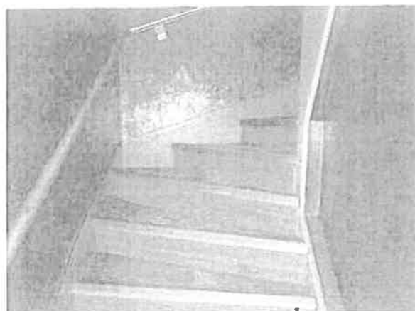
Escalier accès étage
