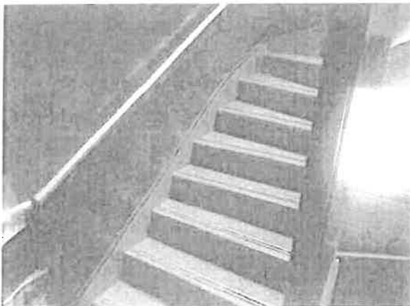
Escalier accès combles
